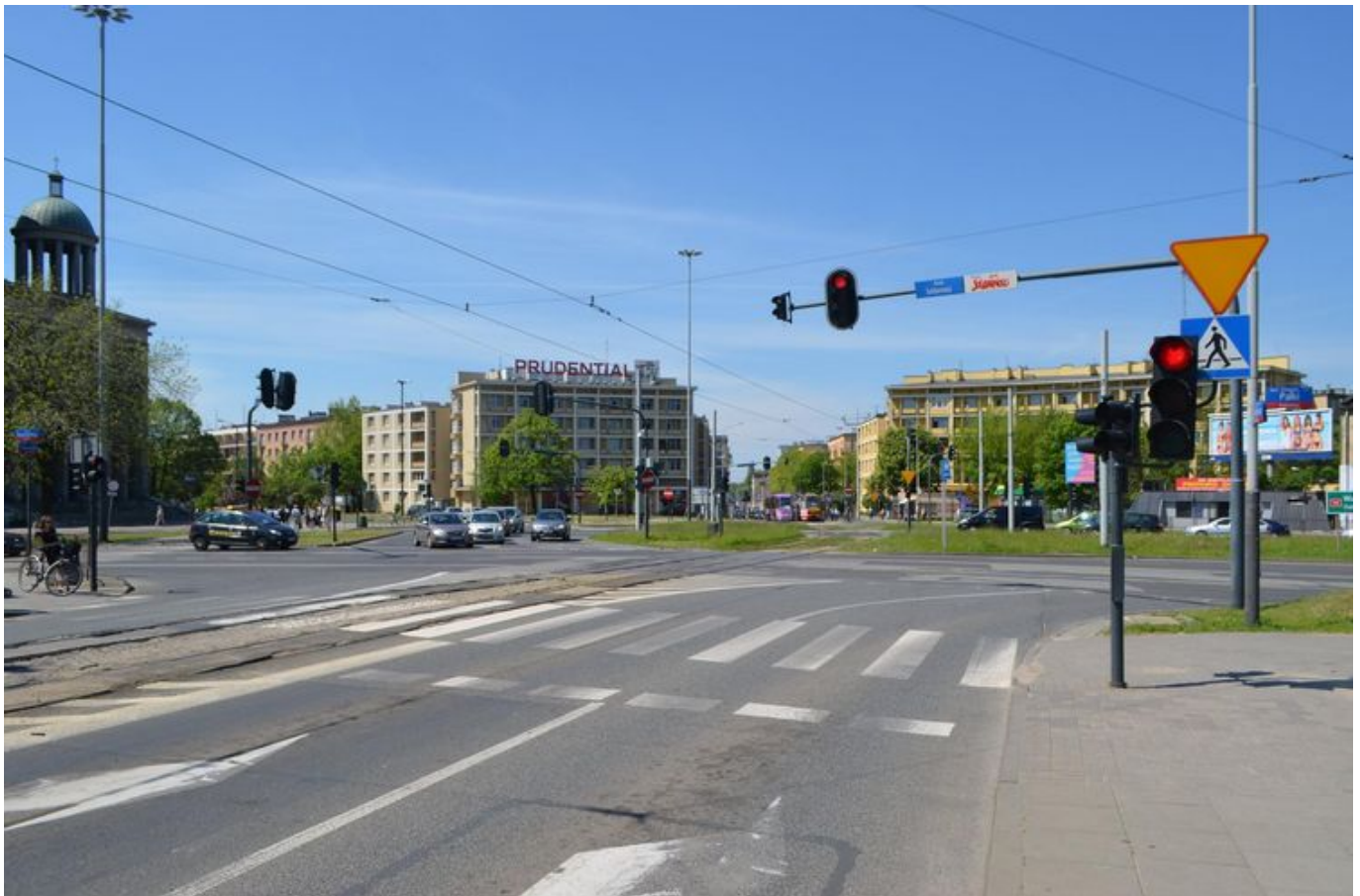
Od niedzieli II etap przebudowy ronda Solidarności , fot. z arch. ZDiT
