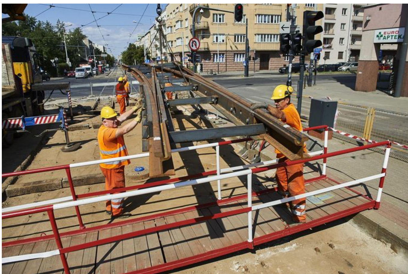
Układamy nowe torowisko na remontowej ulicy Narutowicza , fot. Radosław Józwiak / UMŁ
