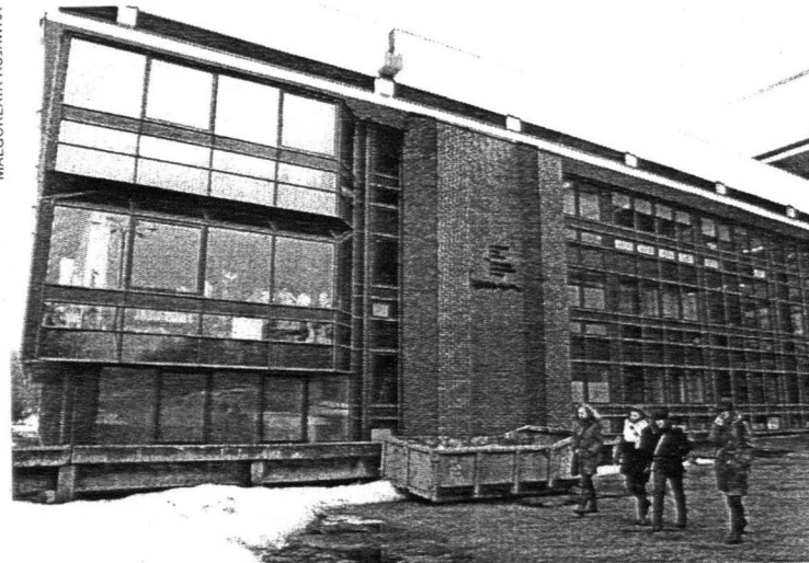
ASP wymieniła m.in. prawie 8 tys. m kw. okien
