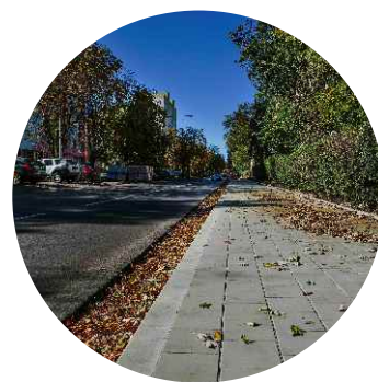
REMONT CHODNIKÓW NA OSIEDLU WIELKOPOLSKA
