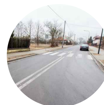
REMONTY ULIC OSIEDLOWYCH
