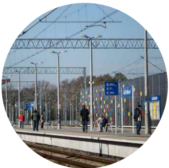
REMONT DWORCA ŁÓDŹ WIDZEW
