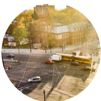
REMONT SKRZYŻOWANIA MARSZAŁKÓW
