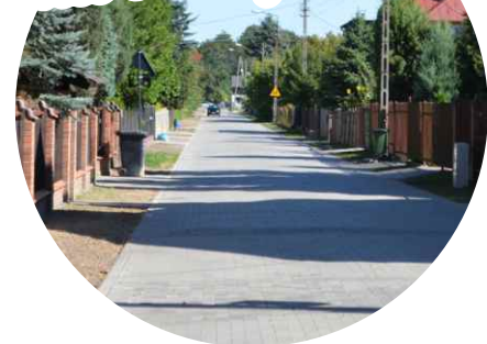
INWESTYCJE NA OSIEDLU ANDRZEJÓW
