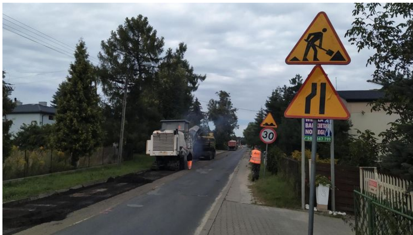
Rozpoczęły się prace przy remoncie ul. Pomorskiej w Nowosolnej
