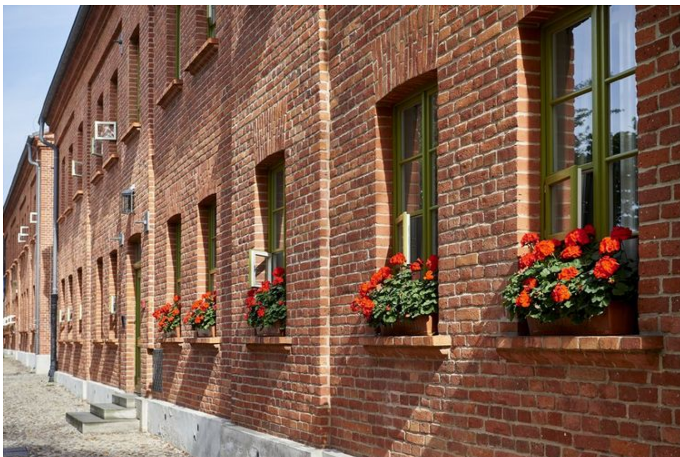
Wystartowały kolejne prace budowlane na Księżym Młynie , fot. Radosław Józwiak / UMŁ
