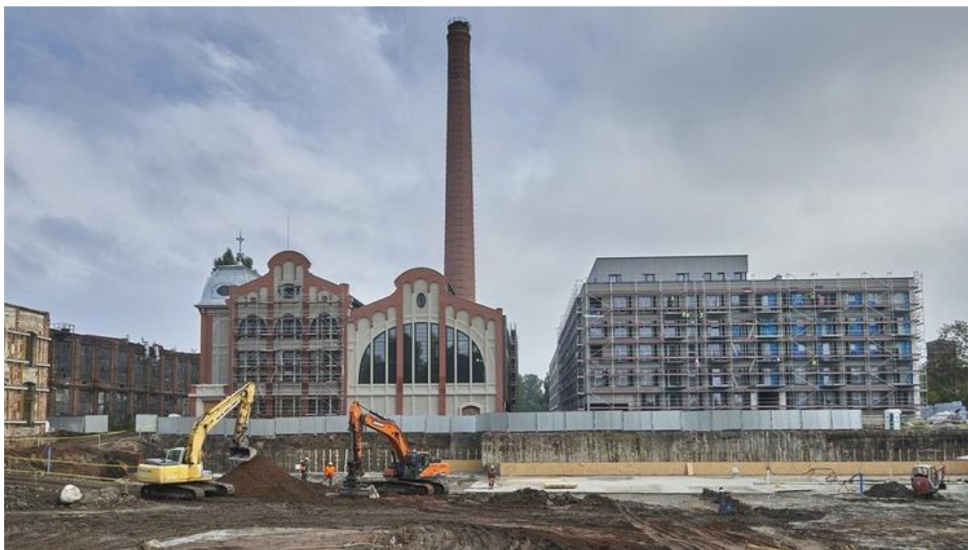
Na terenie pofabrycznego kompleksu Karola Scheiblera rozpoczęła się budowa Fuzji , fot. Radosław Józwiak / UMŁ
