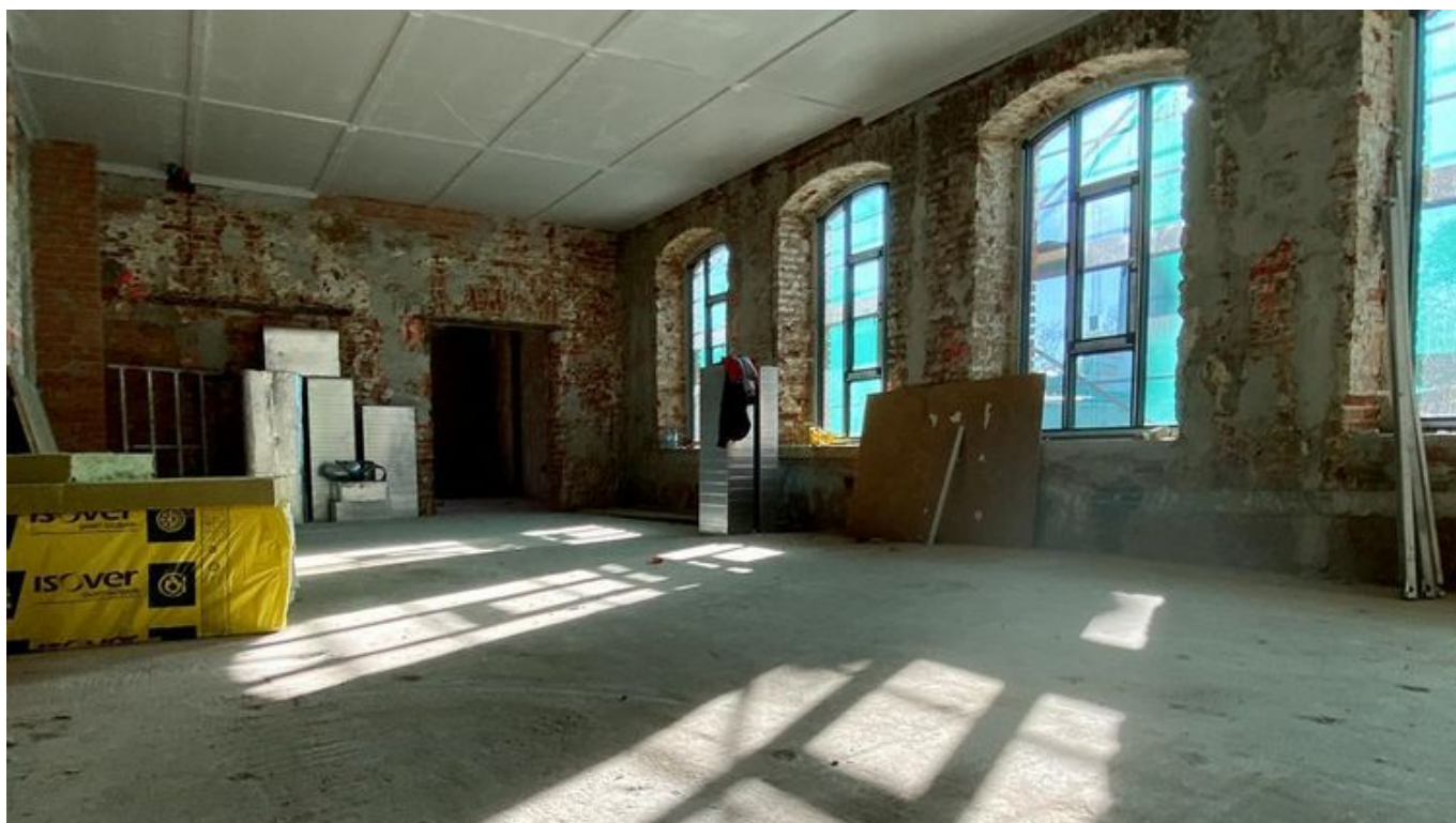
Trwają intensywne prace przy przebudowie zabytkowej fabryki Henryka Wagnera , fot. Stefan Brajter / UMŁ
