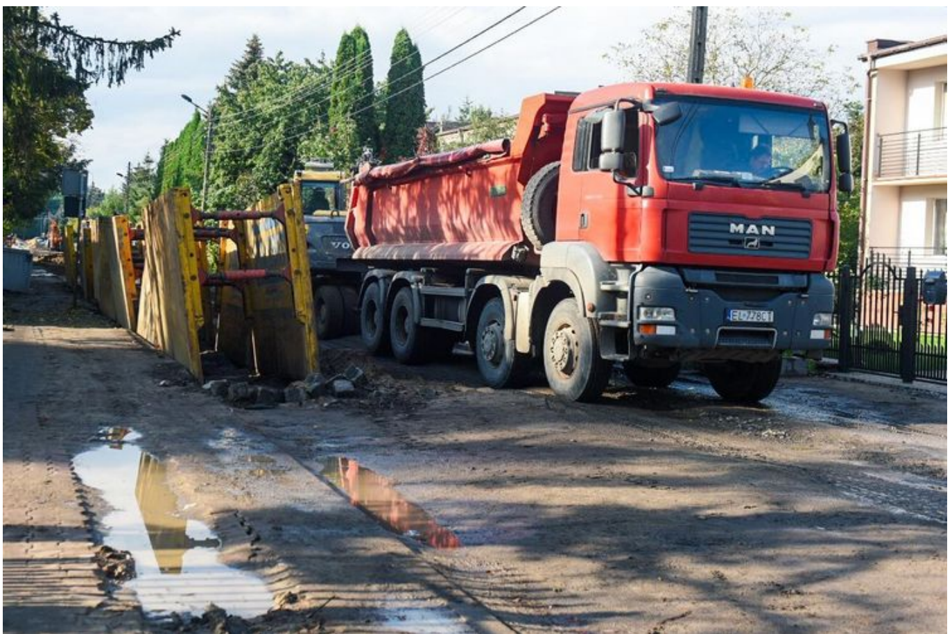
Remont ul. Gajcego na półmetku , fot. Paweł Łacheta / UMŁ
