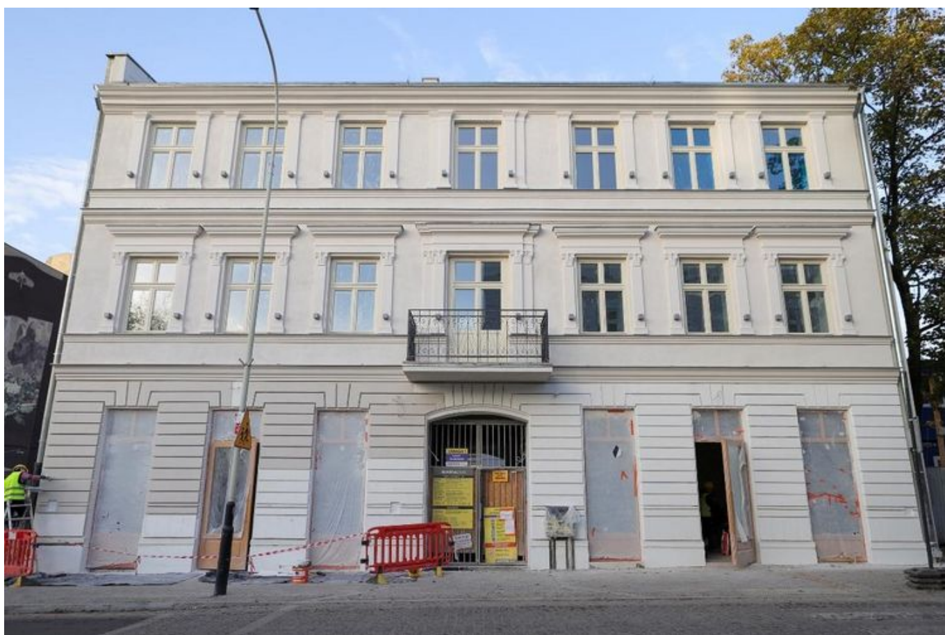
Trwa intensywny remont i przebudowa budynków przy ulicy Sienkiewicza 79
