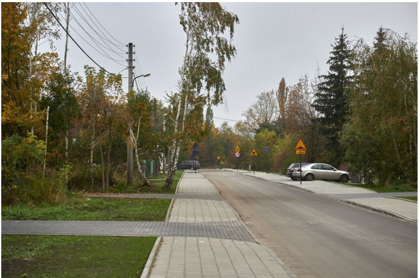
Ulica Wyścigowa już gotowa , fot. Radosław Józwiak / UML
