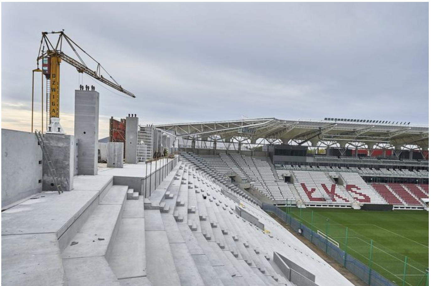
21.10.2020 ŁÓDŹ, ALEJA UNII LUBELSKIEJ BUDOWA STADIONU MIEJSKIEGO ŁKS ŁÓDŹ. ROZPOCZĘCIE MONTAŻU ELEMENTÓW DACHU FOTO RADOSŁAW JOZWIĄK / FOTOCREW
