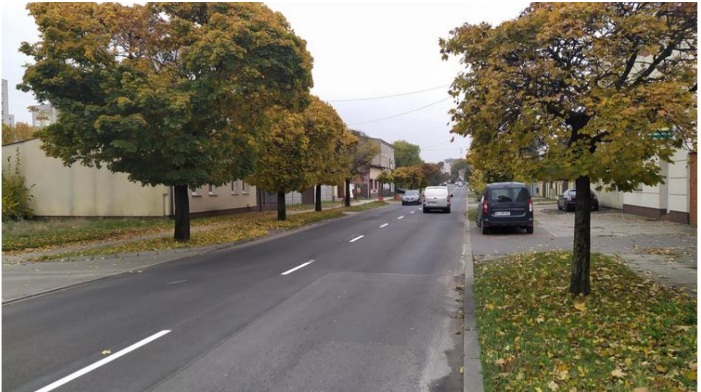
Wymienioną nawierzchnię ma m.in. ul. Kosynierów Gdynskich , fot. ZDiT
