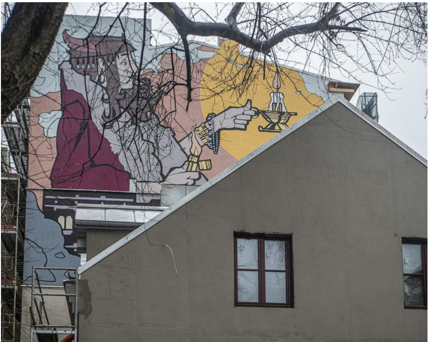
W kamienicy przy ulicy Pomorskiej 11 trwa intensywny remont , fot. Stefan Brajter / UMŁ
