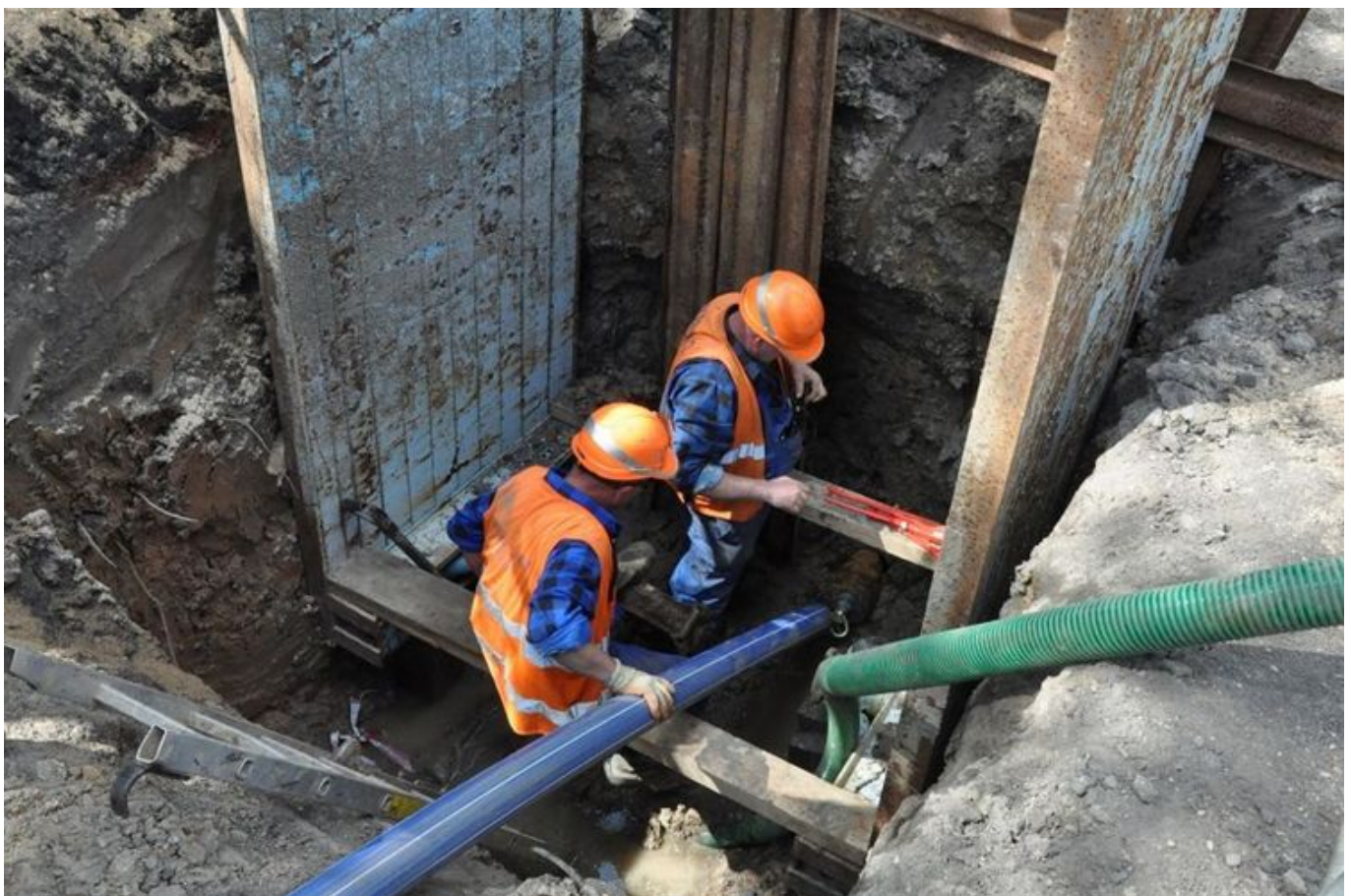
Łódzka Spółka Infrastrukturalna zacznie modernizację wodociągu , fot. z arch. UMŁ
