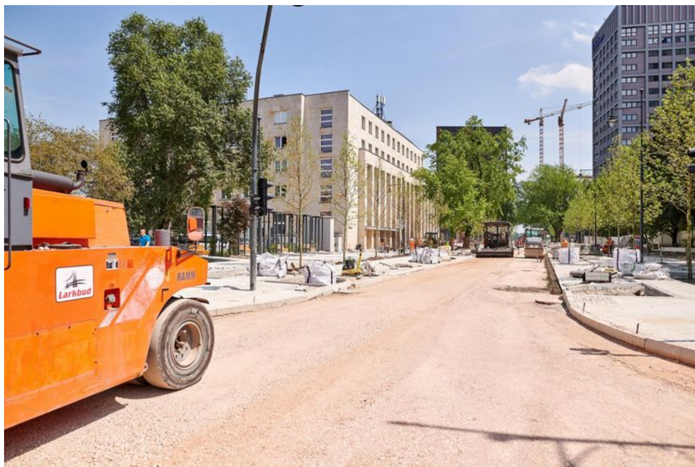
Prace są na ostatniej prostej , fot. Sebastian Glapiński / UMŁ
