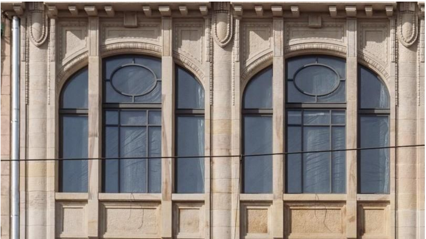
Spodziewano się, że po oczyszczeniu elewacji kamień będzie miał chłodny odcień, tymczasem odkryto ciepłą barwę, fot. Stefan Brajter / UMŁ
