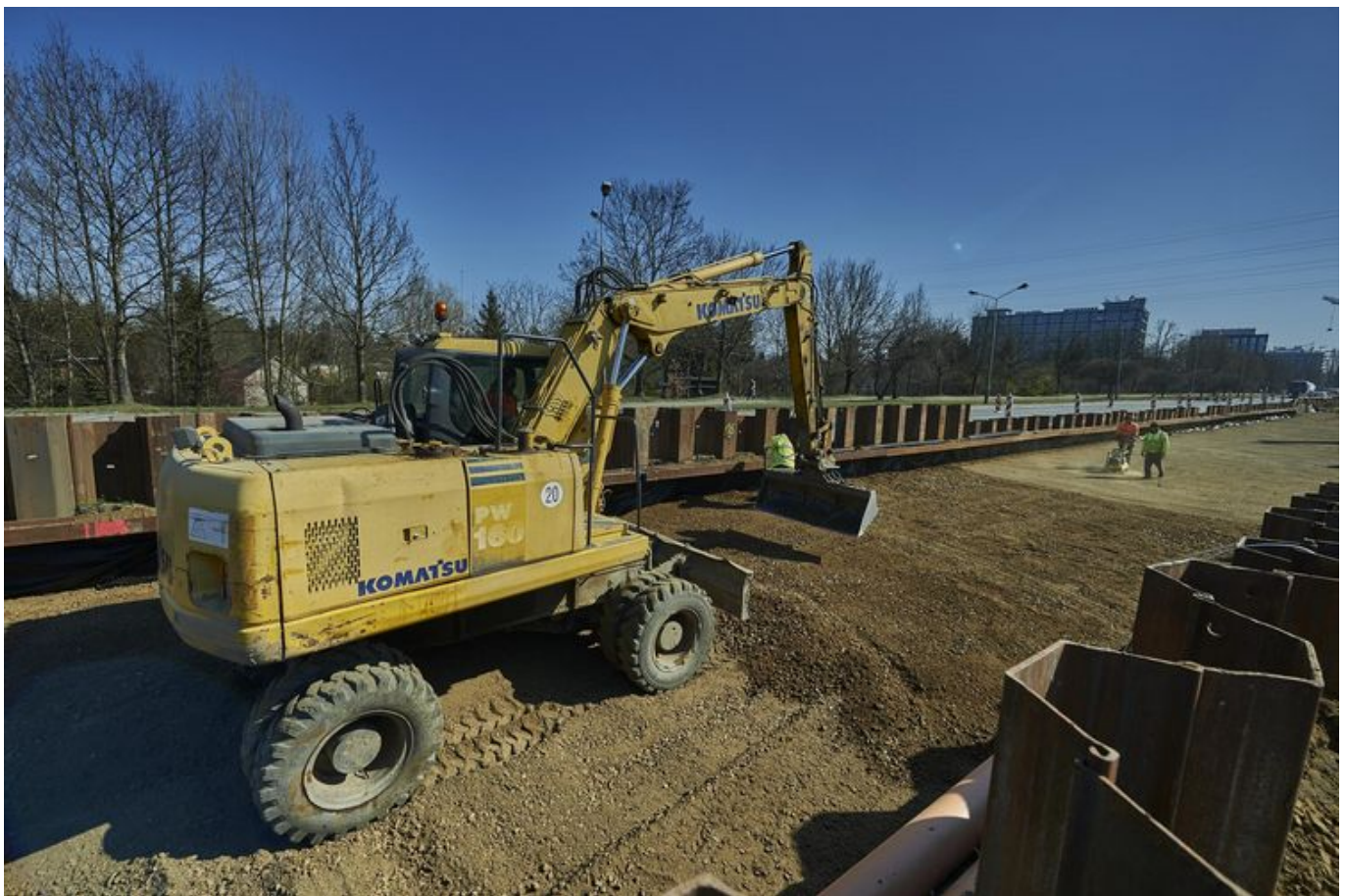
Na Rydza-Śmigłego powstaje nowe torowisko. , fot. Radosław Józwiak
