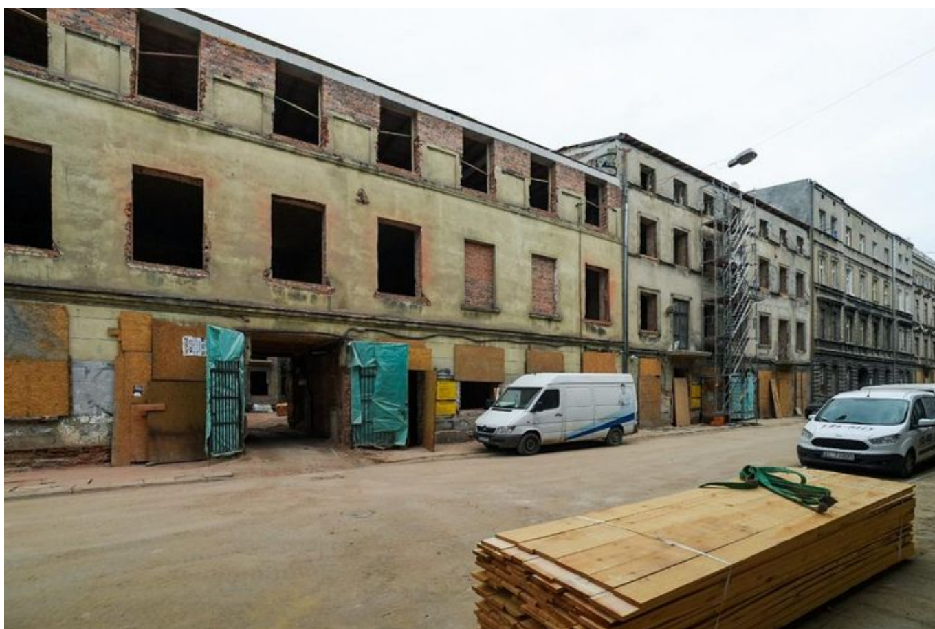
W 13 kamienicach przy ulicy Włókienniczej trwają prace budowlane. , fot. Paweł Łacheta / UMŁ
