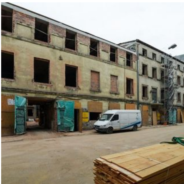
Łódź rewitalizacja. Trwają intensywne prace przy ul. Włókienniczej
