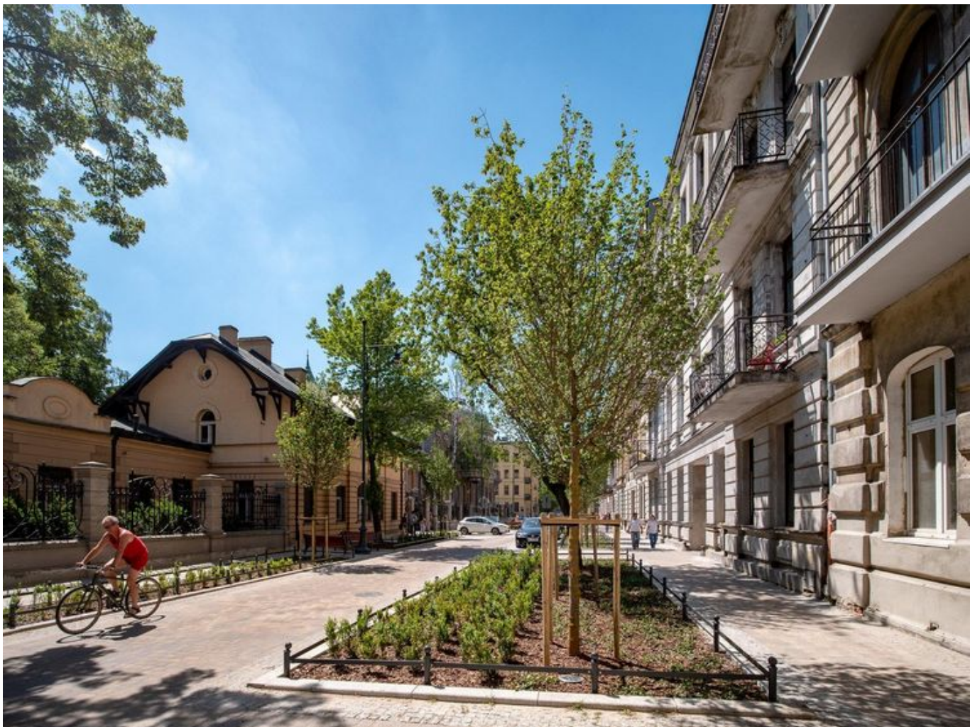
Wyremontowany fragment ul. 1 Maja , fot. z arch. UMŁ
