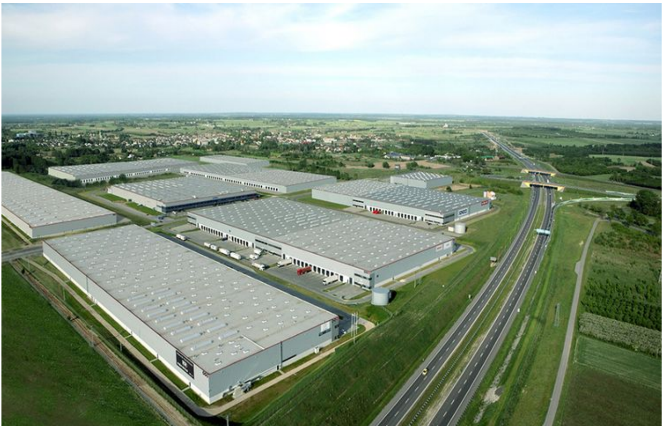
Na terenie Segro Business Park powstaje magazyn firmy JAS-FBG S.A , fot. z arch UMŁ
