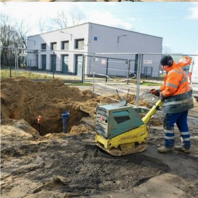
Nowy wodociąg, miejsca parkingowe i drzewa. Trwa remont ul. Wróblewskiego
