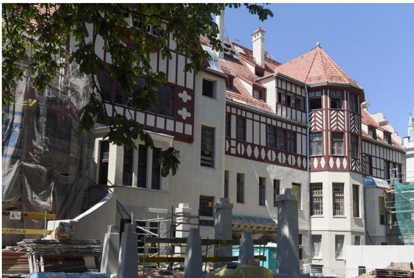
Rewitalizacja Pałacu Steinertów. Widok od strony ogrodu. , fot. Paweł Łacheta
