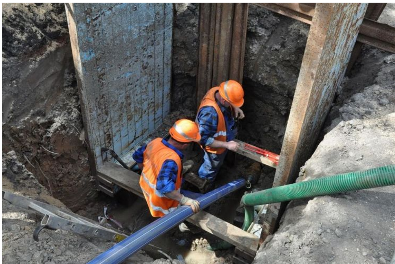
Podłączamy ulicę Podchorążych oraz jej okolice do kanalizacji , arch. UMŁ
