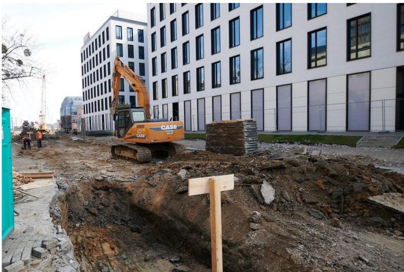
Budujemy podziemną drogę w Nowym Centrum Łodzi , fot. Sebastian Glapiński / UMŁ
