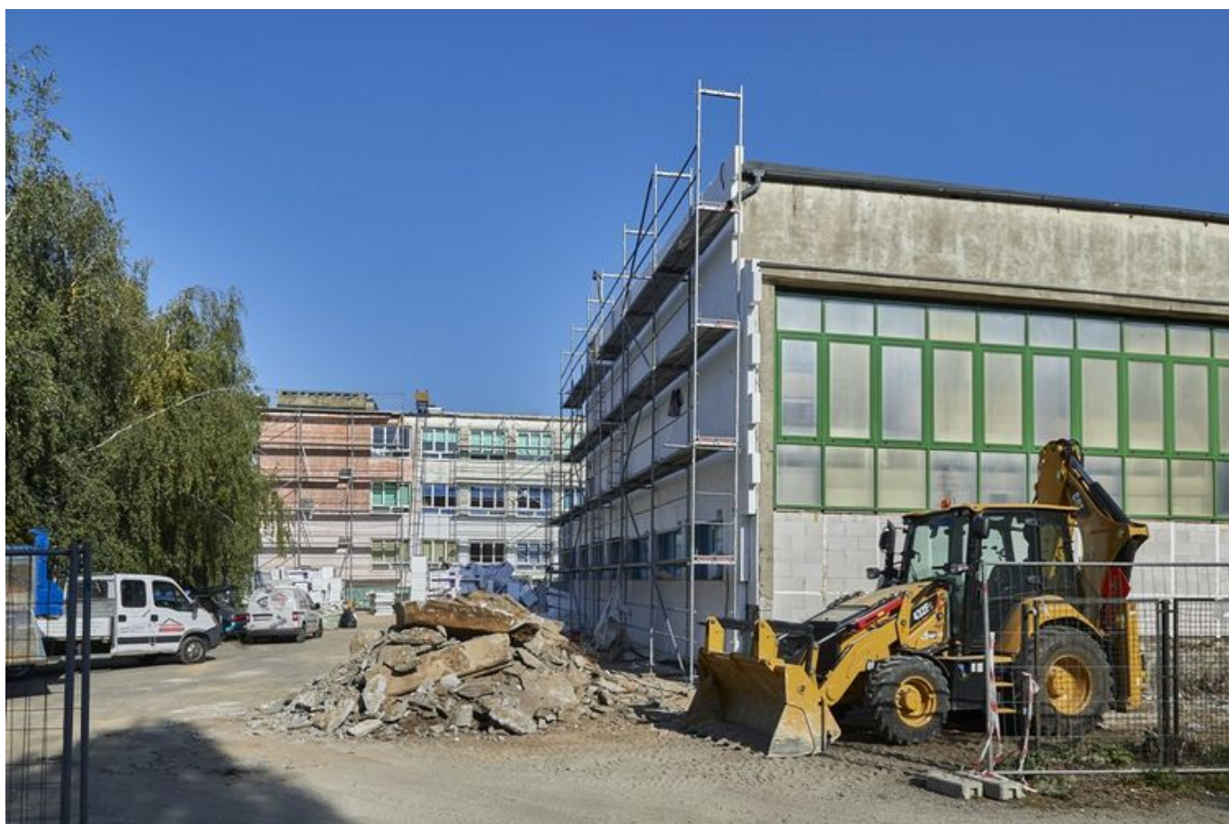
Termomodernizacja budynku Szkoły Podstawowej nr 11 przy ul. Hufcowej 5 , fot. Radosław Józwiak / UMŁ
