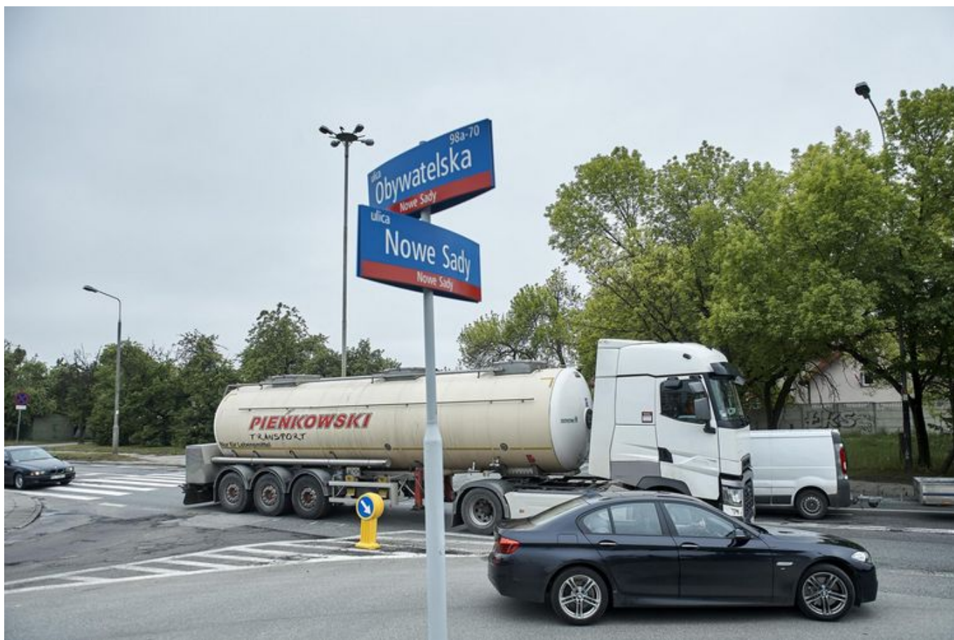
Ronda, remont jezdni i chodników, droga dla rowerów. Ulica Obywatelska do przebudowy , fot. Radosław Józwiak / UMŁ
