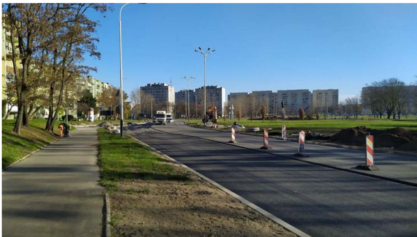
Układamy nowy asfalt na al. Wyszyńskiego i kończymy remonty nawierzchni ulic w tym roku , mat. UMŁ
