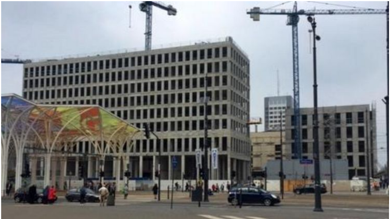
Budowa kompleksu Hi Piotrkowska , mat. prasowe
