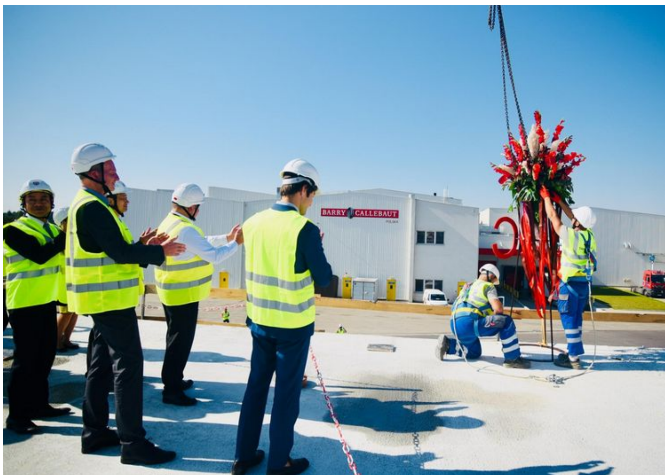
Zawieszono wiechę na budowie hali do produkcji czekolady zastalanej , fot. Paweł Łacheta / UMŁ
