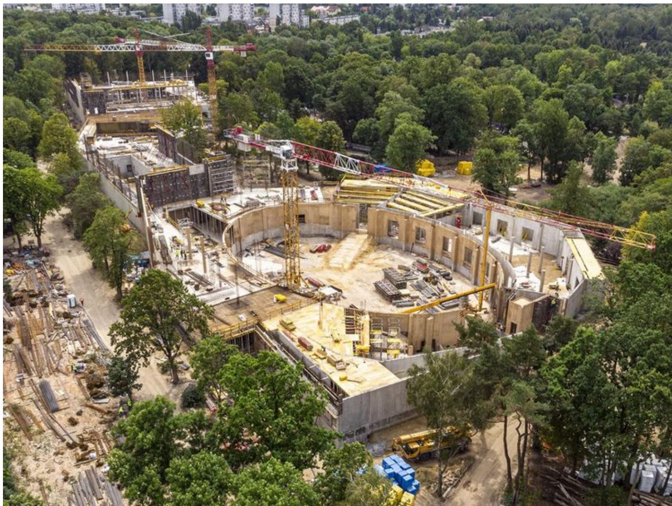
Prace nad Orientarium są mocno zaawansowane , mat. UMŁ
