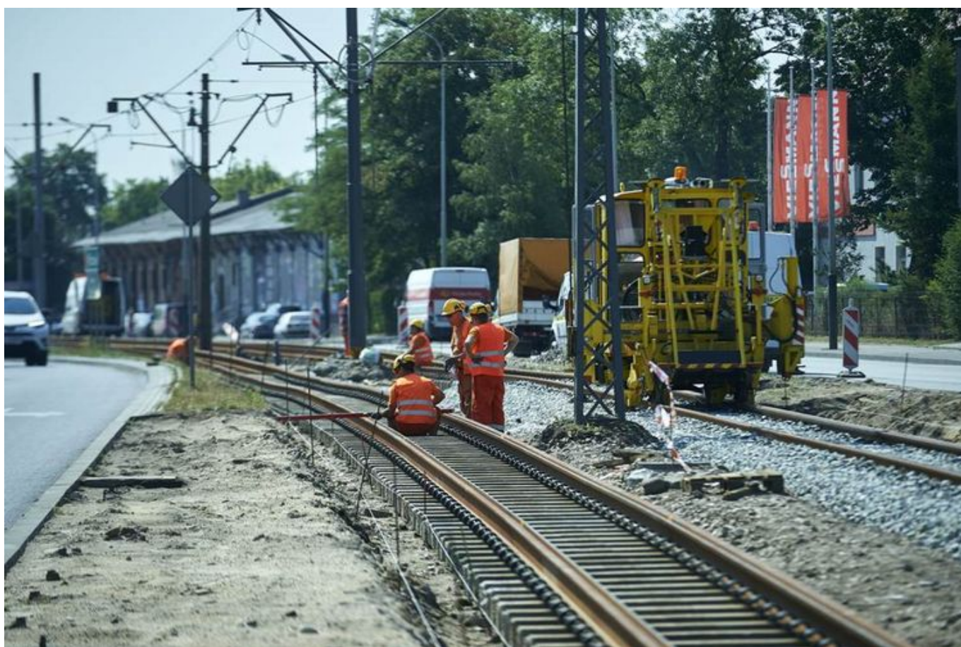
Układamy nowe torowisko na al. Włókniarzy , fot. Radosław Józwiak / UMŁ
