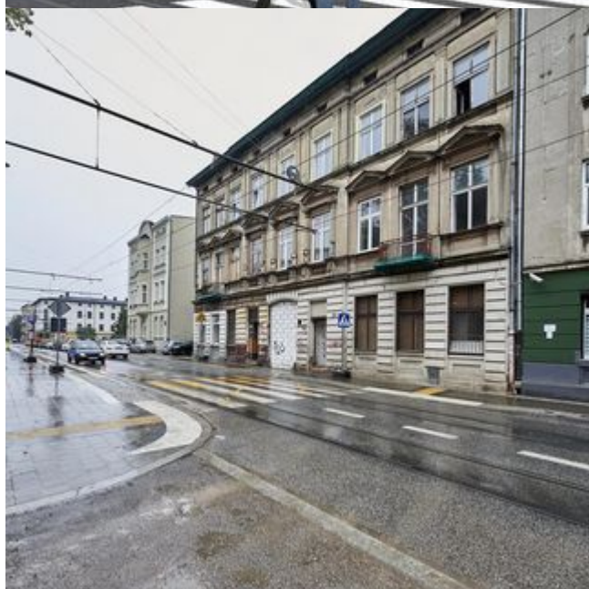
Łódź rewitalizuje. W zabytkowej kamienicy przy ul. Kilińskiego powstaną wygodne mieszkania komunalne i lokale usługowe
