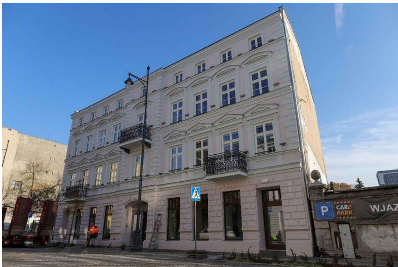
Dobiega końca remont kamienicy przy ul. Sienkiewicza 56 , fot. Konrad Ciężki / UMŁ
