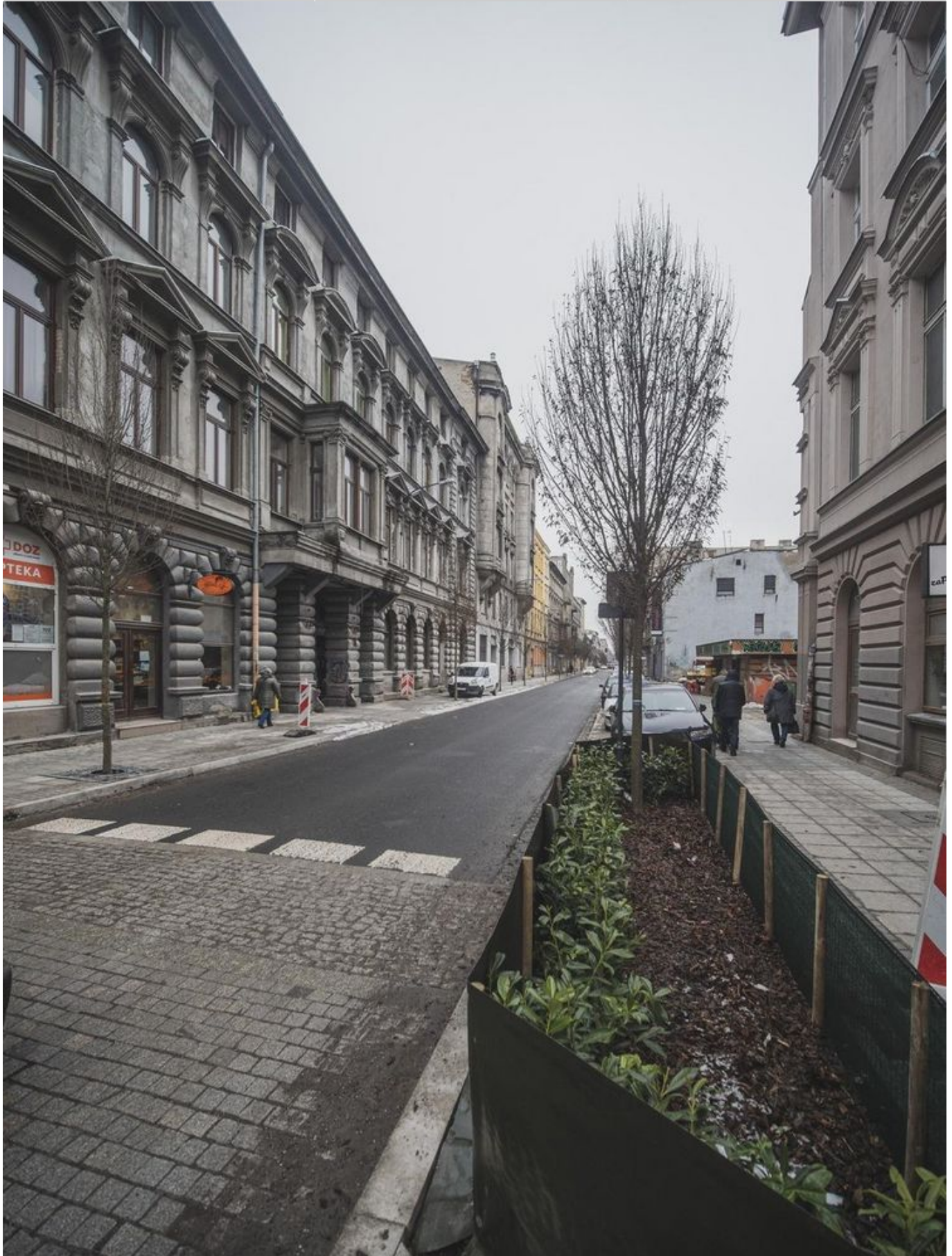
Remont ulic Próchnika i Rewolucji 1905 roku rozpoczął się na początku 2020 roku.
