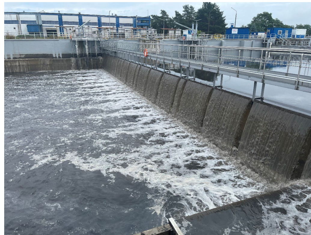
Napełnianie zbiorników, przelew ścieków ze zbiornika 2.7 do 2.8
