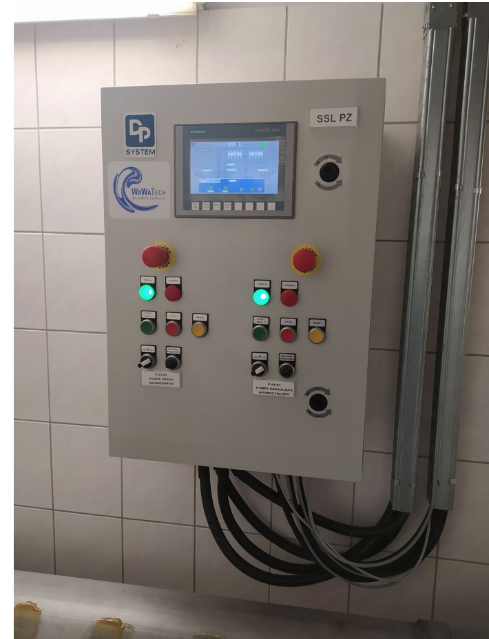
Szafa sterowania lokalnego pomp i aparatury kontrolno-pomiarowej
