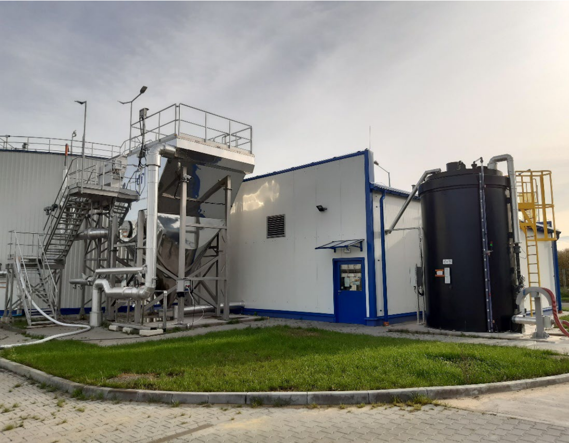
Zbiornik deamonifikacji, separator lamelowy, budynek techniczny, zbiornik NaOH.
