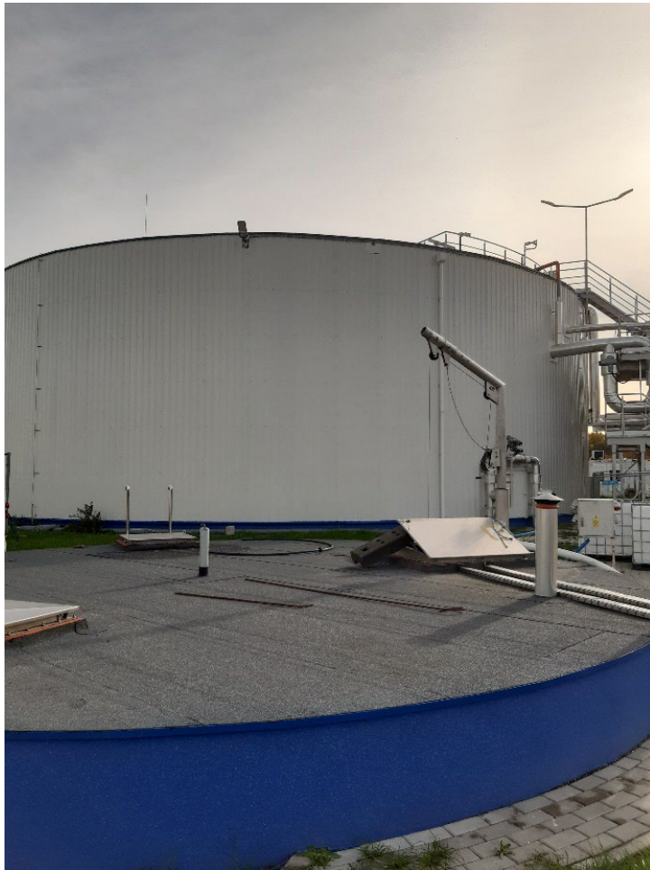
Zbiornik buforowy odcieków, w tle zbiornik deamonifikacji.
