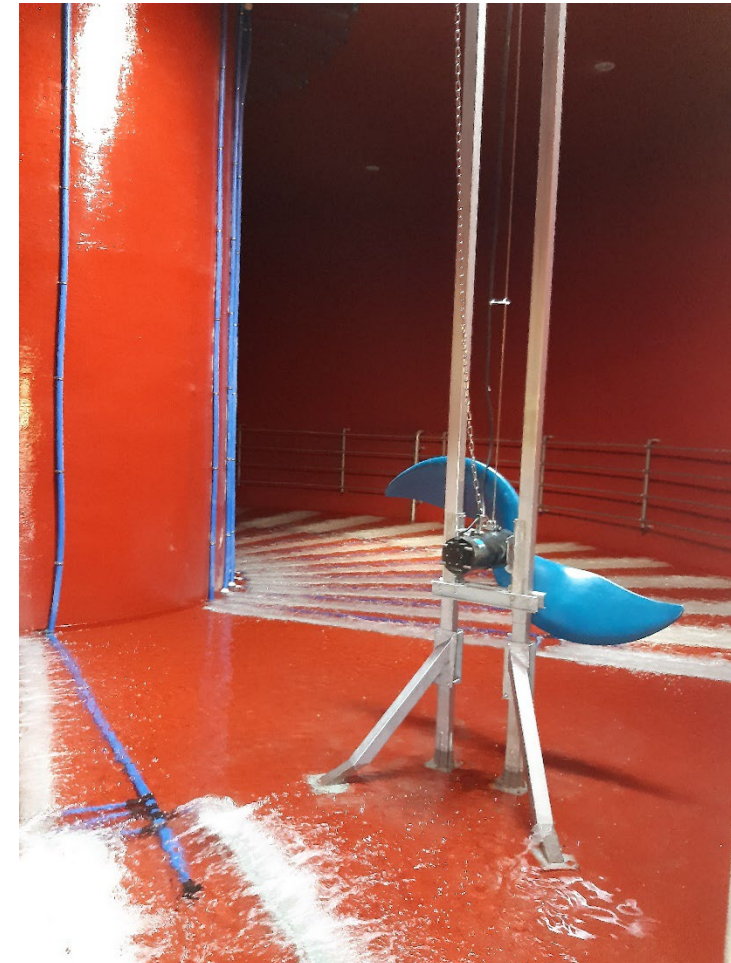
Wnętrze zbiornika procesowego deamonifikacji wraz z systemem napowietrzania, mieszadłem i węzownicą.
