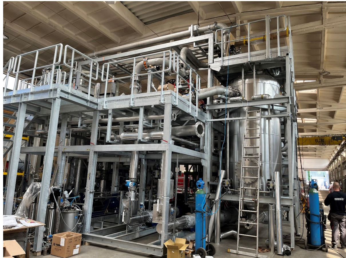
Instalacja hydrolizy – montaż w zakładzie produkcyjnym.
