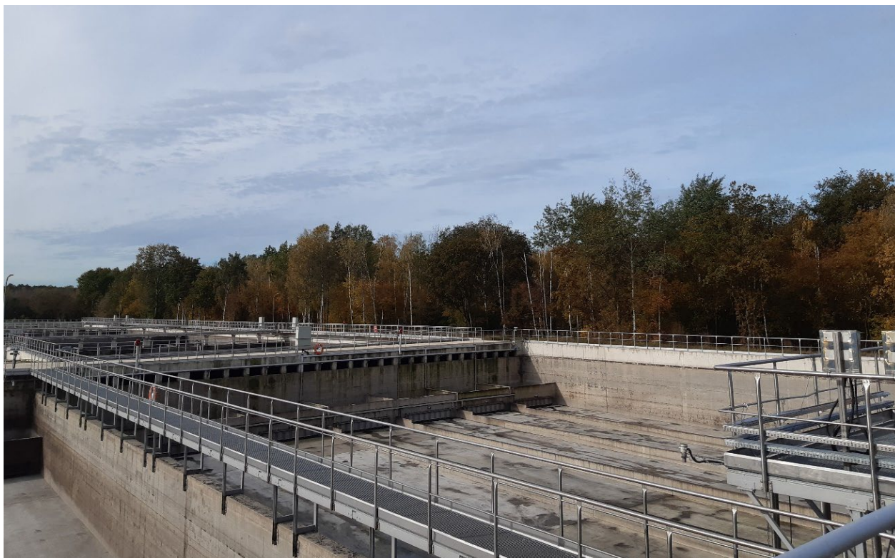
Zbiornik retencyjny 2.8, w tle zbiorniki 2.9-2.12.
