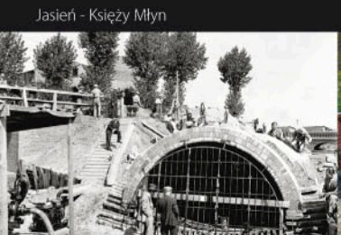
Budowa krytego koryta, ul. Piękna
