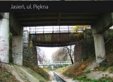
Wiadukt PKP nad Jasieniem dziś
