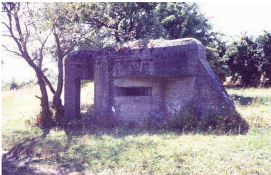
Betonowy schron bojowy – gniazdo ckm 28 pSK. Glinno. VIII 2008 r. Fot., zbiory autora pracy
