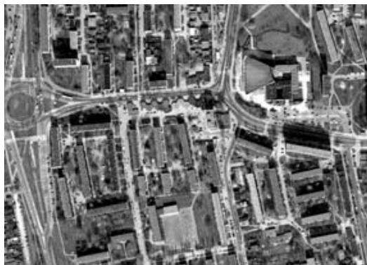
Pod koniec XVIII w. powstała huta szkła w kolonii Chojny, a potem osada Dąbrowa.
