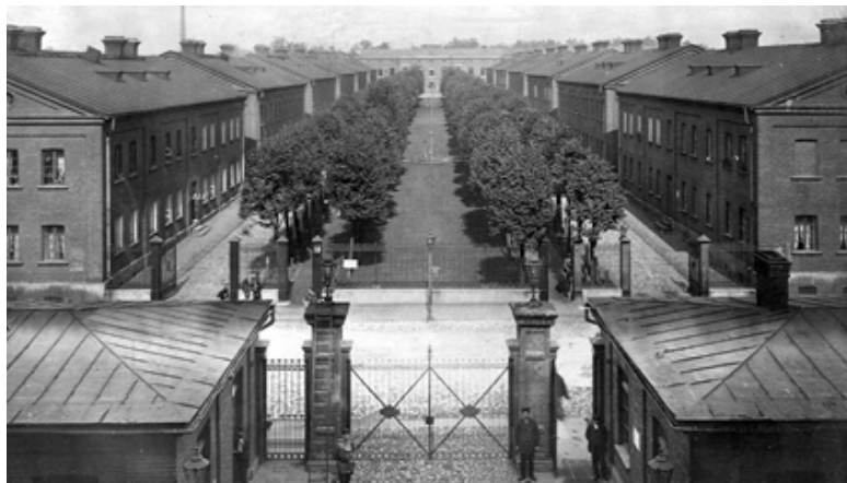
Osiedle domów robotniczych na Księżym Młynie, widok od strony fabryki.
