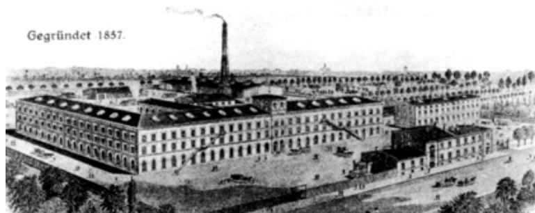
Coraz więcej fabryk z braku miejsca lokowano poza śródmieściem. Powyżej fabryka wełniana Karola Kretschmera przy ul. Milscha (obecnie Kopernika).
