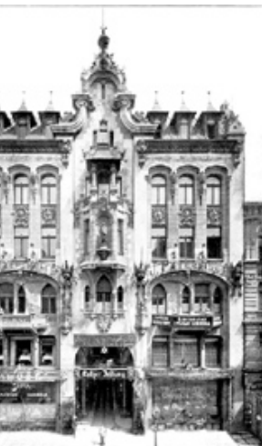
Kamienica pod Gutenbergiem przy ul. Piotrkowskiej 86, w której w latach 1897-1915 mieściły się zakłady J. Petersilge.
