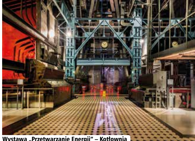
Wystawa „Przetwarzanie Energii” – Kotłownia
