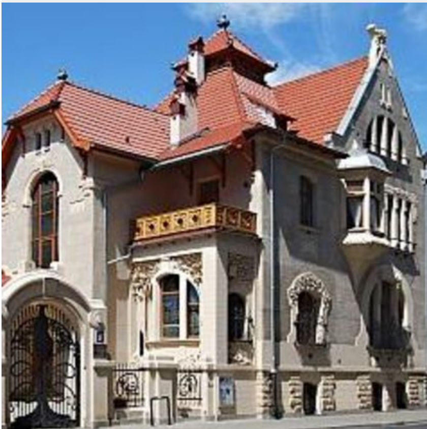
Galeria Willa/ Galeria Chimera, fot. MGSŁ
